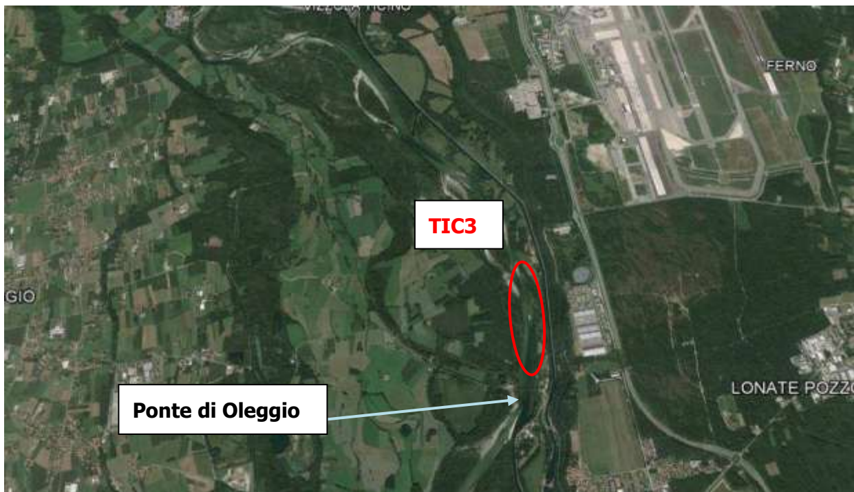
Figura 3-47 Localizzazione del tratto TIC3 oggetto di studio.
