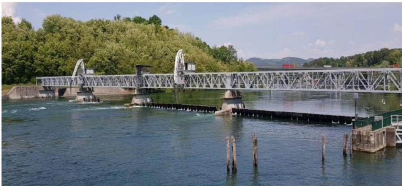
FIGURA 11. SBARRAMENTO DELLA MIORINA E, SULLA DESTRA, LE PRIME DUE CAMPATE E LE VENTOLE IN FUNZIONE
