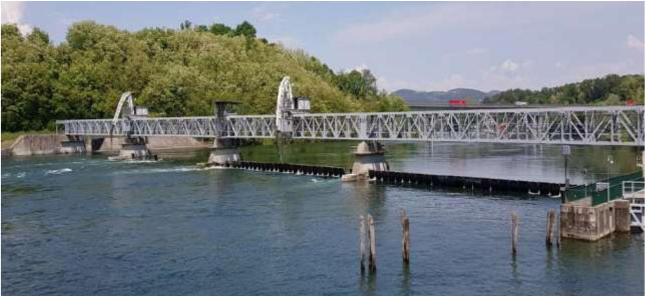
FIGURA 13. SBARRAMENTO DELLA MIORINA, CON IN EVIDENZA, SULLA DESTRA, LE PRIME DUE CAMPATE E LE VENTOLE IN FUNZIONE
